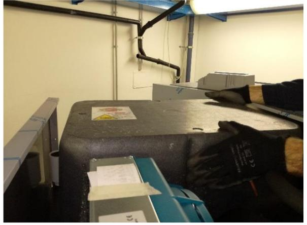
**15.** Den Sicherheitsriemen an der Isolierungshaube schließen.
