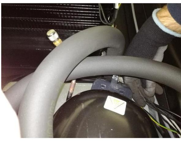
10. Die Schellen befestigen und die Drähte erneut an den entsprechenden Klemmen anschließen.
