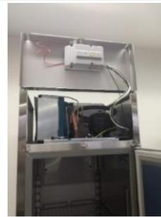
3. Das Gas mit dem entsprechenden Rekuperator zur Lagerung des Kältemittels von der Anlage entfernen.
