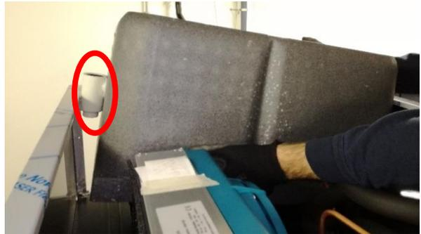
5. Die Befestigungsschrauben des Verdampfers lösen.
