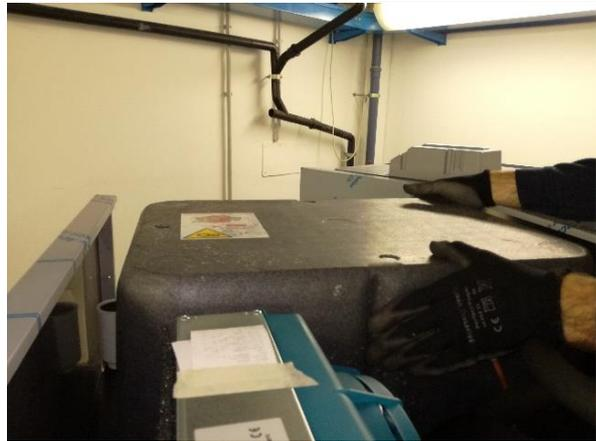
**16.** Den Sicherheitsriemen an der Isolierungshaube schließen.
