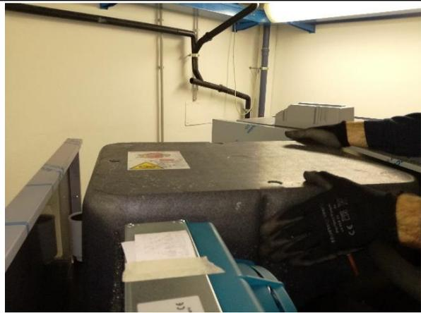
**18.** Den Sicherheitsriemen an der Isolierungshaube schließen.
